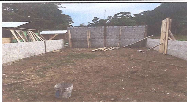
Foto 1: Se observa el avance de las hiladas de block.
