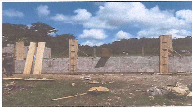
Foto 2: Colocación de tablas para las columnas.
