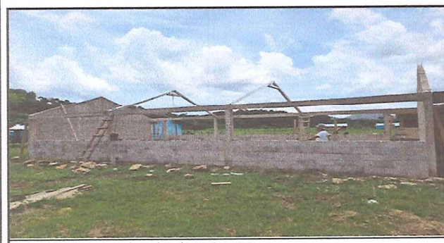
Foto 5: inicio de la colocacion de costaneras.
