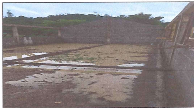
Foto 4: Se observan los inicios para la colocacion de piso.
